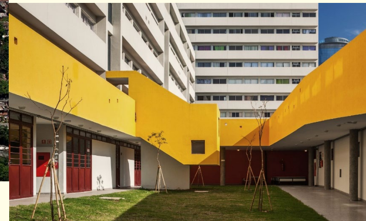
Conjunto Habitacional do Jardim Edite / MMBB Arquitetos + H+F Arquitetos. LOCAL: Brooklin, próximo à Ponte Estaiada. Foto © Nelson Kon
